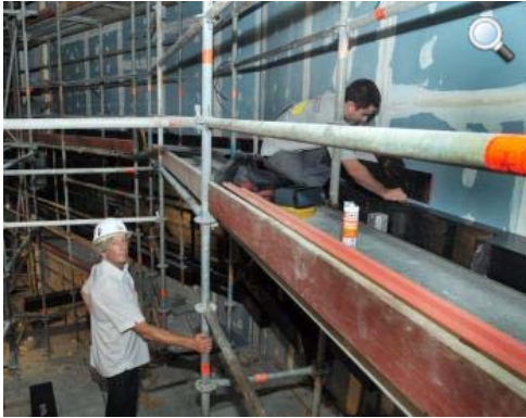
Pose des caissons acoustiques dans la salle de spectacle du Grand théâtre. /Photo DDM, Emile Cayre.
